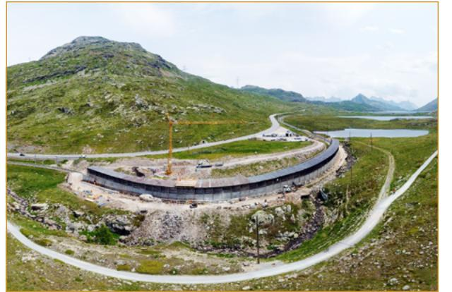
La Gallaria Arlas es grida fabricheida il an 1909 scu proteciun dals binaris cunter ils scuflos. Pervi cha la construziun nu accumplicha pù las exigencias d'hozind, la stu esser ruota giò e construida da nouv. In agiunta vegn la gallaria schlungida vers il pass per 20m.
